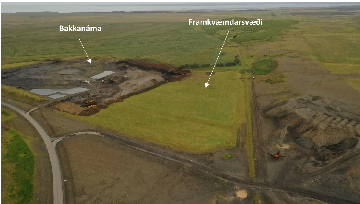
MYND 4.5 Yfirlit yfir framkvæmdarsvæðið, horft til norðurs. Vestast sést Bakkanáma og fyrirhugað framkvæmdarsvæði er fyrir miðri mynd. Eins og sjá má á myndinni þá standa nokkrar aspir norðan fyrirhugaðs framkvæmdarsvæðis. Mynd: EFLA, 2021
