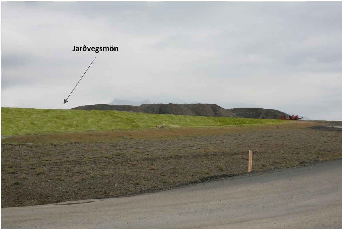
MYND 4.11 Líkanmynd frá myndatökustað 4 sem sýnir ásýnd svæðisins eftir framkvæmdir. Á myndinni sést jarðvegsmönin greinilega en ekki gryfjan sjálf. Jarðefnalager í Skorholtsnámu sést greinilega.
